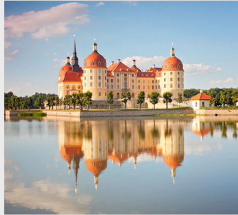
Schloss Moritzburg Mechanische Schließanlage
