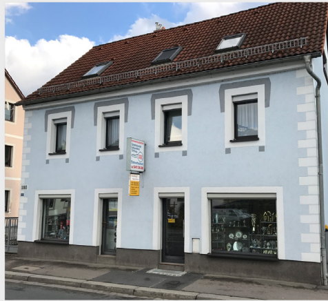
Dresdner Straße 345 in Freital vor dem Umbau
