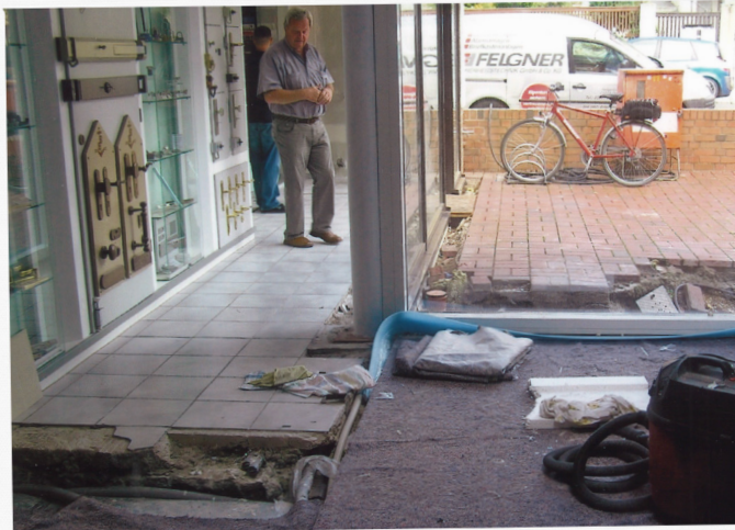
Zwischen Alt- und Neubau
