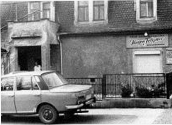
Vor der Renovierung: das Haus Heiligenbornstraße 17 im Urzustand
