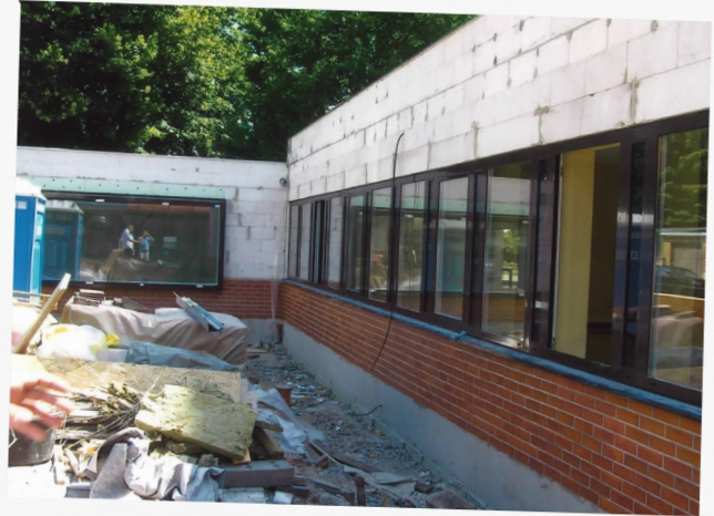
Der Rohbau von der Seite
